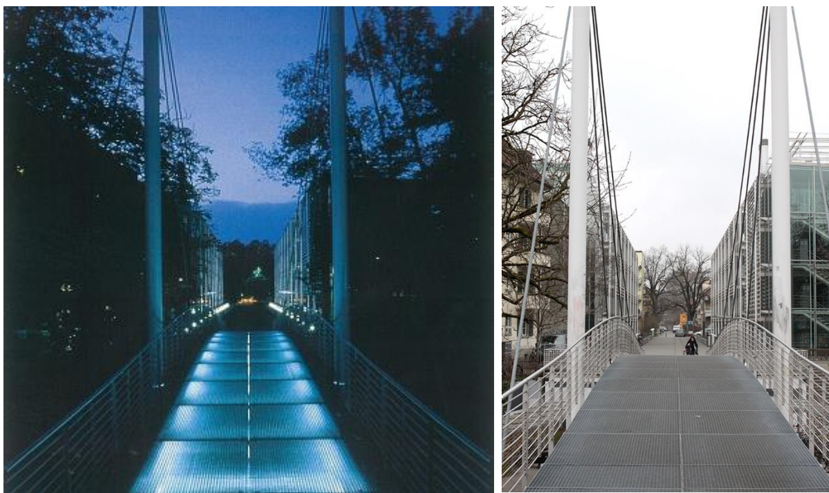
Ill. 2 + 3 : Max Neuhaus, Suspended Soundline , installation sonore avec haut-parleur et construction métallique, 1999
